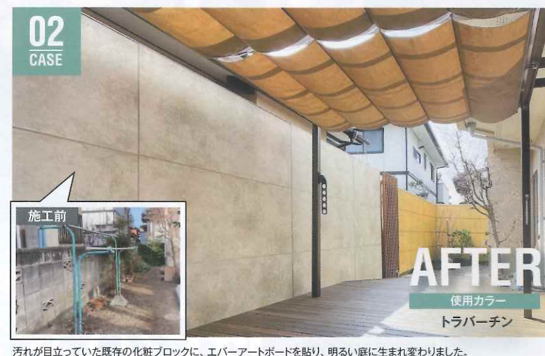
汚れが目立っていた既存の化粧ブロックに、エバーアートボードを貼り、明るい庭に生まれ変わりました。
