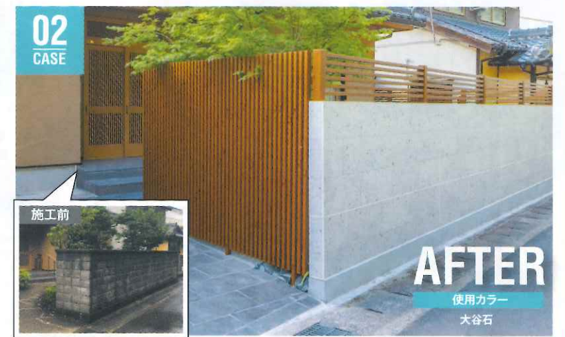
既存のブロック塀にエバーアートボードを貼るだけで、美しく明るい印象に。
